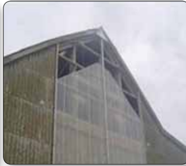
Photo 9 : Exutoires en façade de magasin (YARA France)
