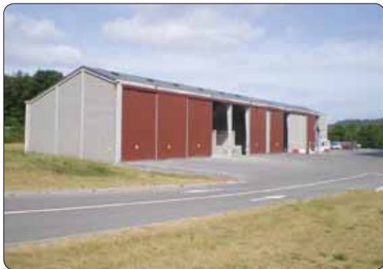
Photo 1 : Magasin de stockage (ACOLYANCE)
