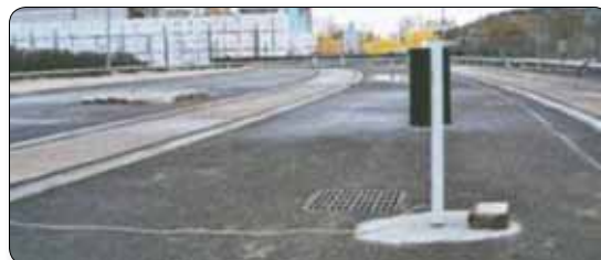
Photo 7 : Détecteurs anti-intrusion (YARA France)
