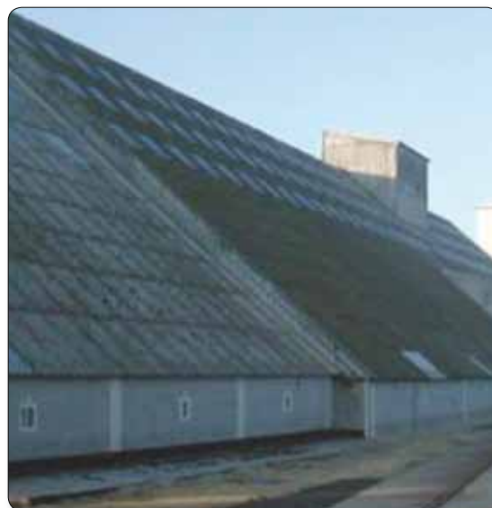
Photo 13 : Repérage extérieur des cases engrais (YARA France)
