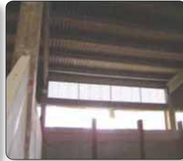
Photo 10 : Ouverture permanente en partie haute des bâtiments au dessus des cases (Coopérative Agricole Lorraine 54)
